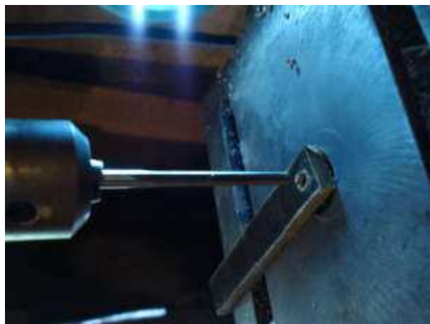
Les emplacements des pivots sont prêts.
